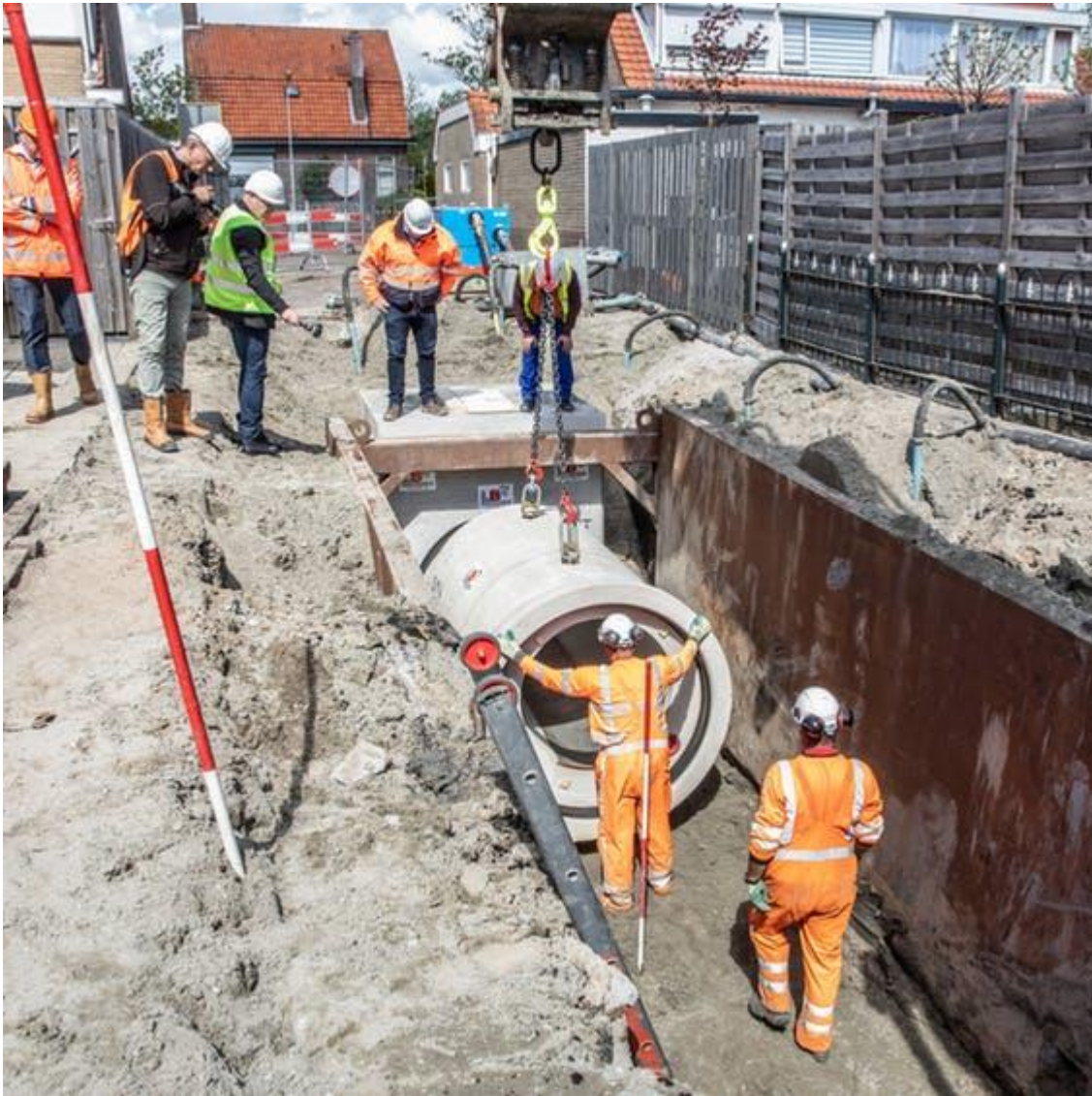
Aanleg van riothermie in Goes. Foto: Marcelle Davidse
